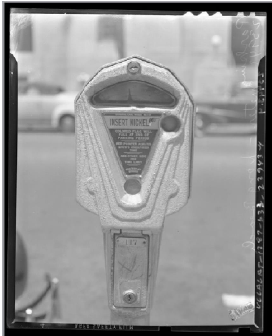
Le premier parcomètre installé en 1935 à Oklahoma City (Source : UCLA Library)
