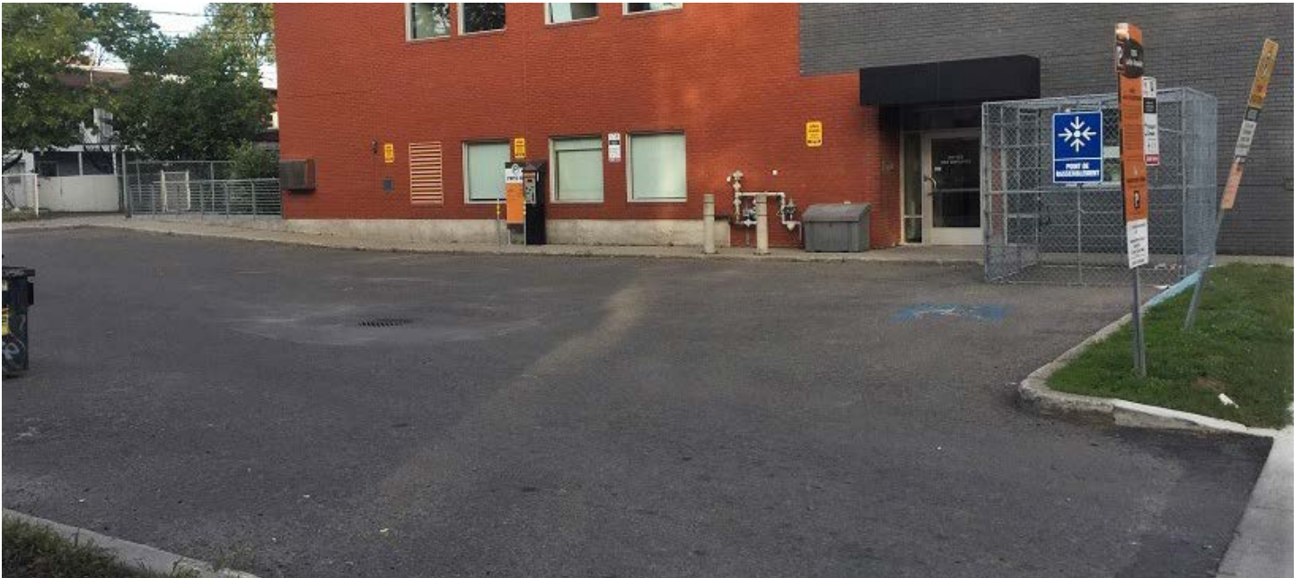
Le stationnement situé au nord du bâtiment du CLSC Hochelaga-Maisonneuve
