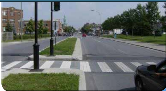
Passage pour piétons à mi-tronçon sur une artère. Arrondissement Villeray - Saint-Michel - Parc-Extension
