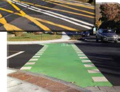
Marquage bande cyclable Ville de Brossard
