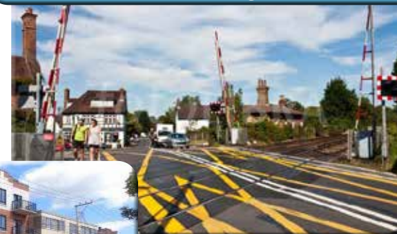
Passage à niveau sécurisé. Lyndhurst, Grande-Bretagne
