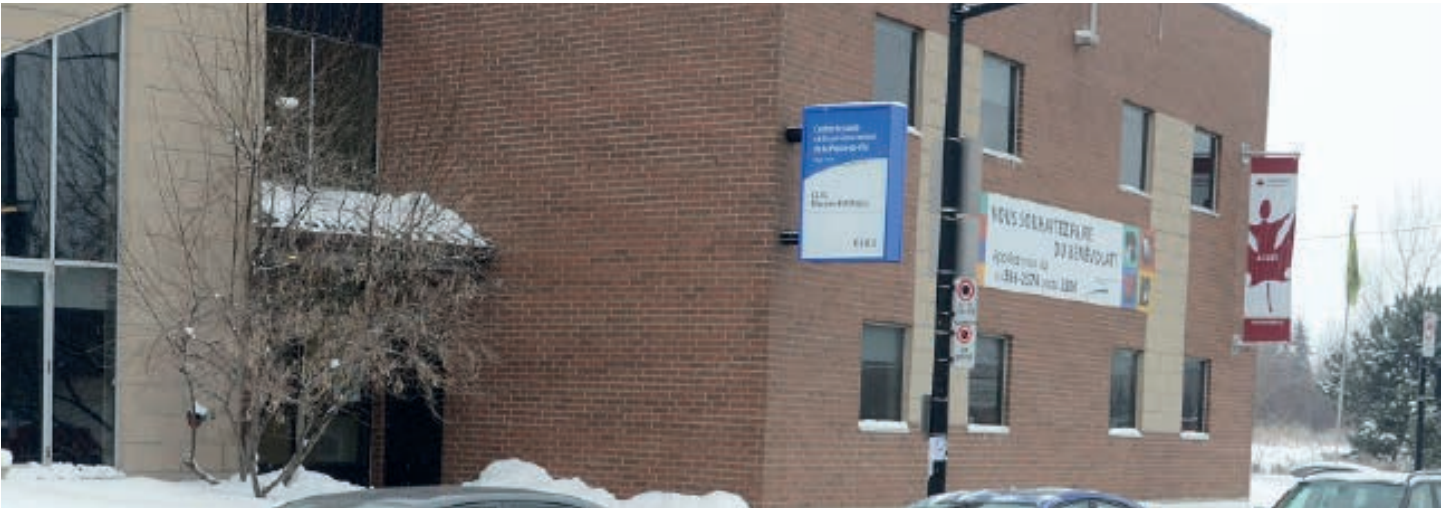
CLSC MERCIER-EST—ANJOU localisé sur la rue Sherbrooke Est, à l'angle de la rue Contrecoeur.
