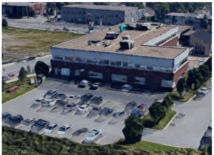
Le stationnement situé au nord du CLSC Mercier-Est—Anjou possède quelques arbres qui contribuent timidement à la lutte aux îlots de chaleur.
